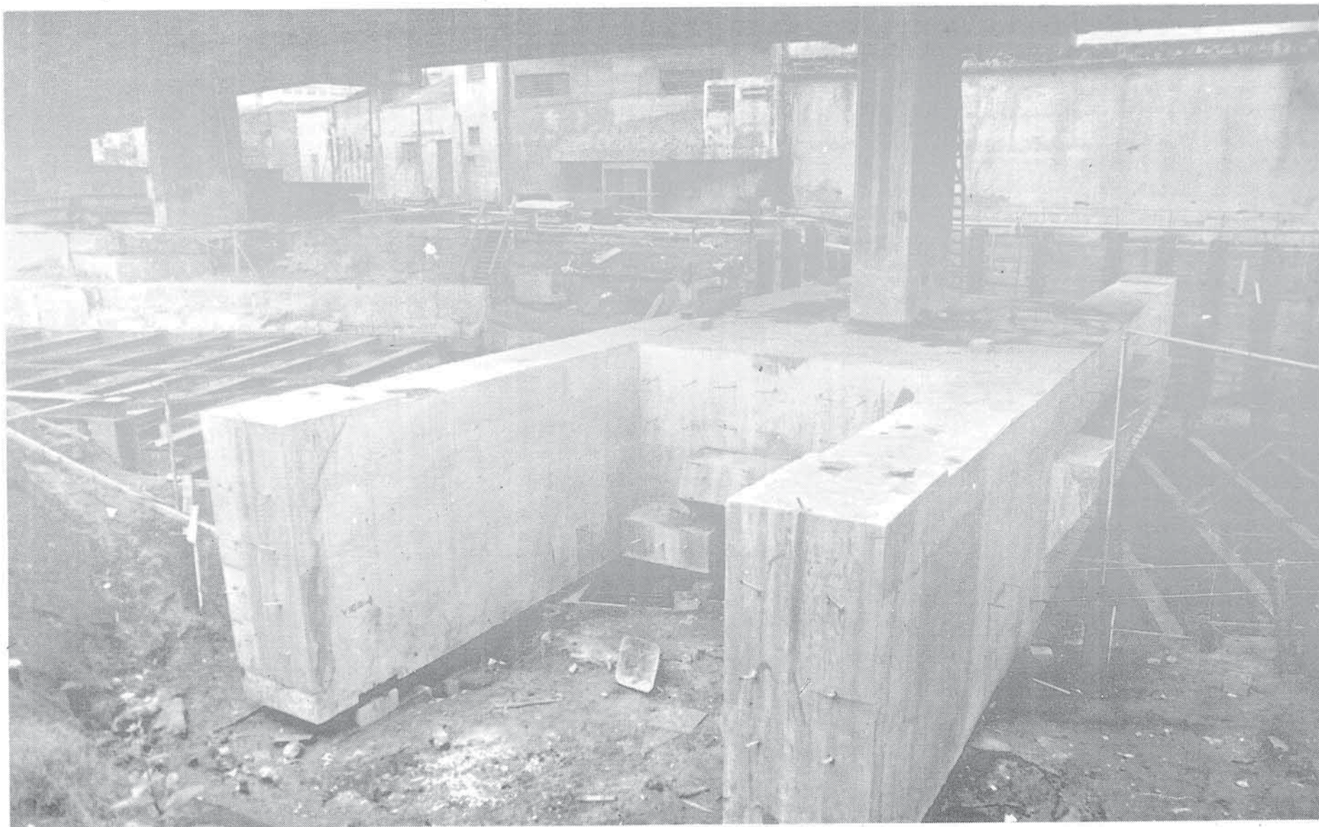
Foto 15 - Vista geral da sub fundação.
