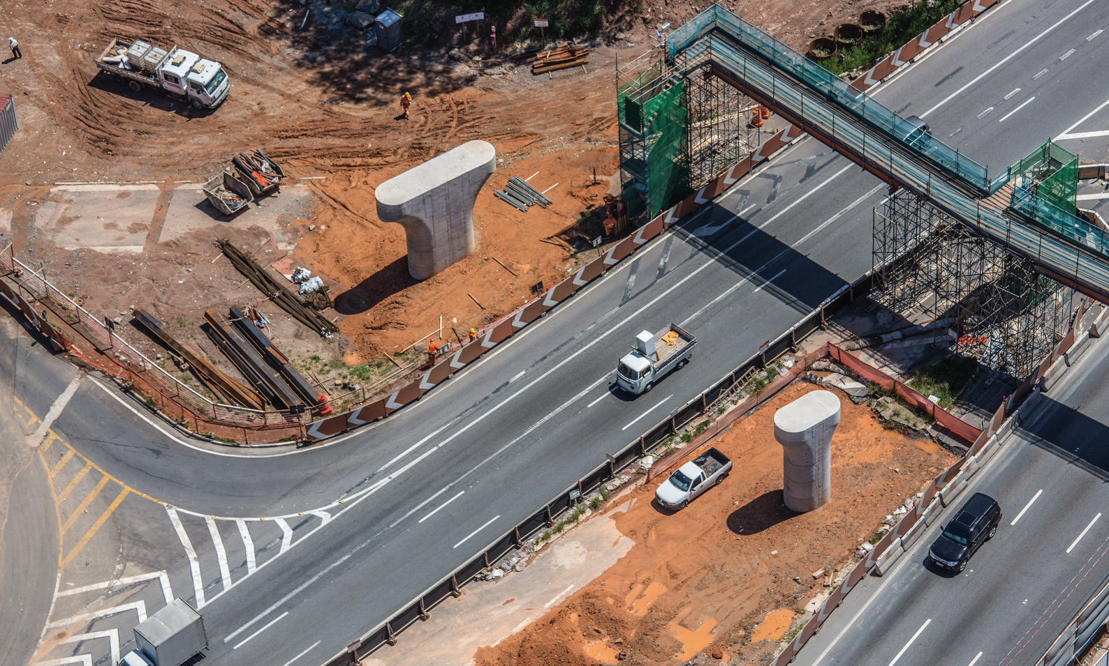
A OPÇÃO PARA OS PILARES FOI DE ESTACAS ESCAVADAS, COM EXCEÇÃO DO APOIO AP4, ONDE SE USOU TUBULÃO A AR COMPRIMIDO
