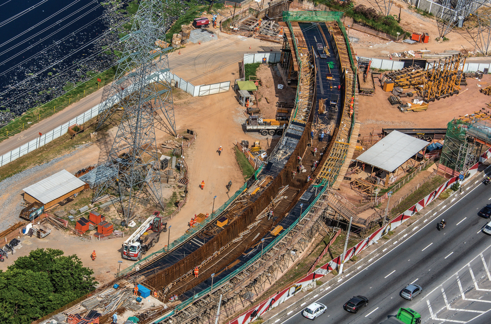
A OBRA TEVE DE CONVIVER COM TRÂNSITO, ALÉM DE OBSTÁCULOS COMO REDE DE ENERGIA ELÉTRICA E O LEITO DO RIO PINHEIROS
