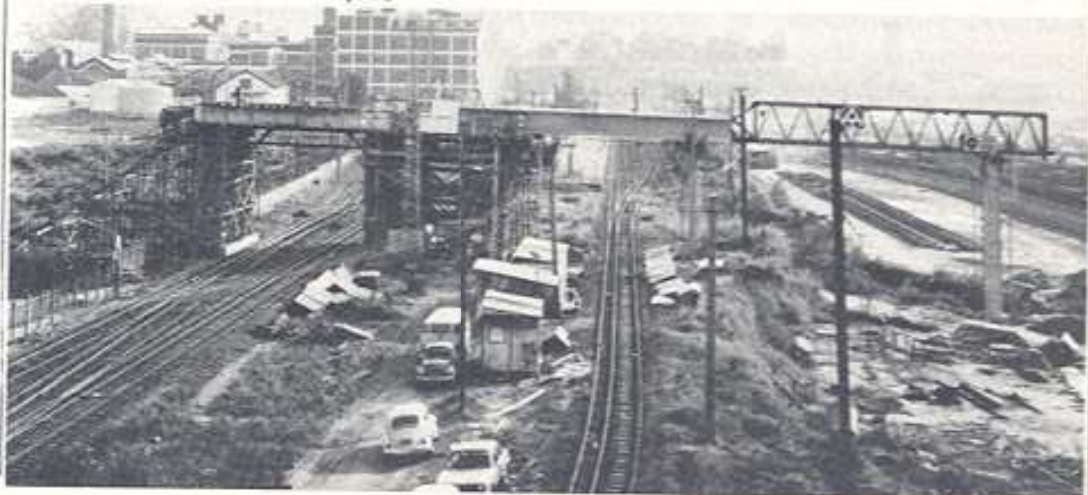
Vista geral do 1º módulo lançado
