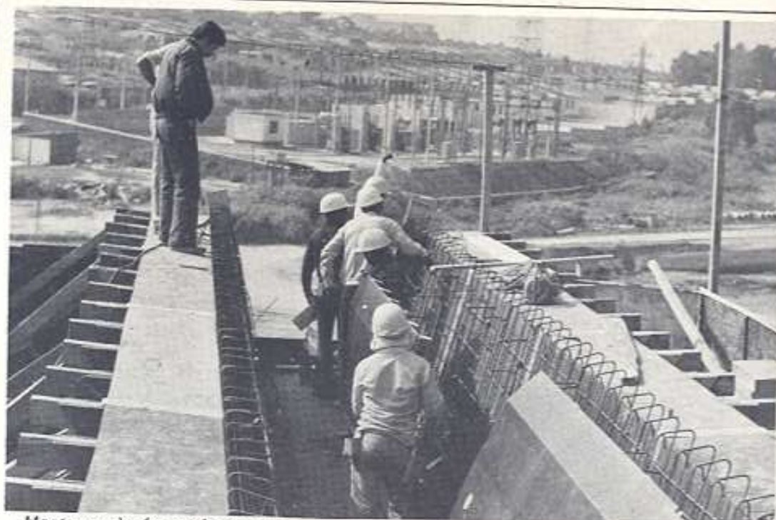
Montagem das formas internas
