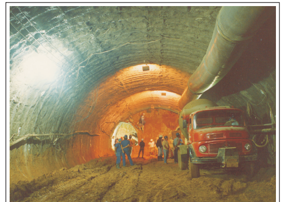
Escavação do Túnel
