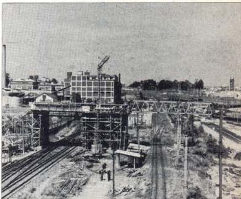
A TRELIÇA está pronta para deslocar o primeiro módulo, que foi produzido no canteiro de 200 m — situado à esquerda da foto.
