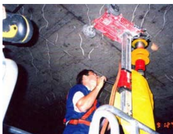
Foto 1 - Panorama Típico de Fissuração da Reação Alcalis-Agregado
